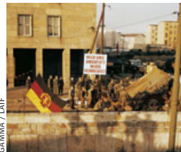
August: Die Arbeiten zum Bau der Berliner Mauer beginnen
