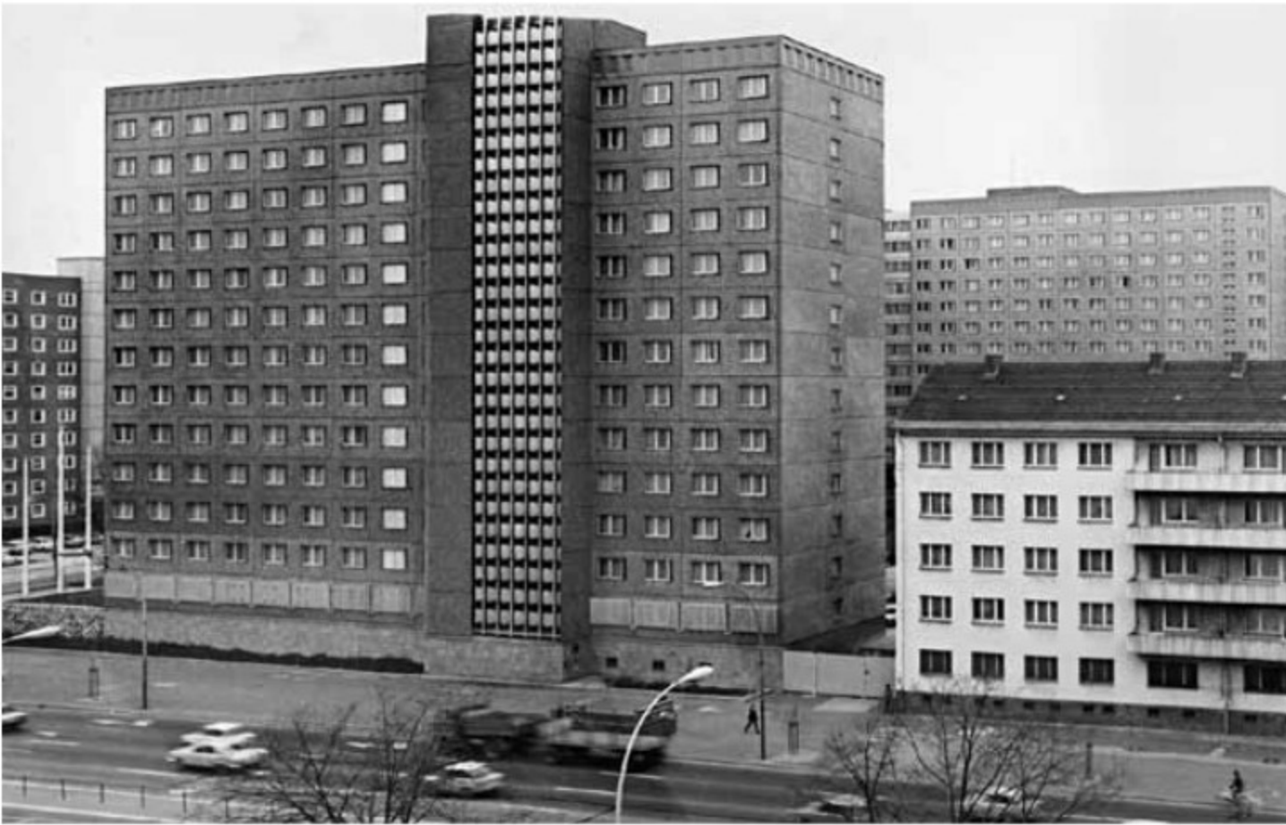
Gebäude der Auslandsspionage HVA an der Frankfurter Allee im Ost-Berliner Stadtbezirk Lichtenberg innerhalb des großräumigen Komplexes des Ministeriums für Staatssicherheit
